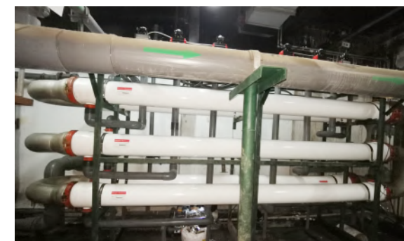
ATMF医院废水
